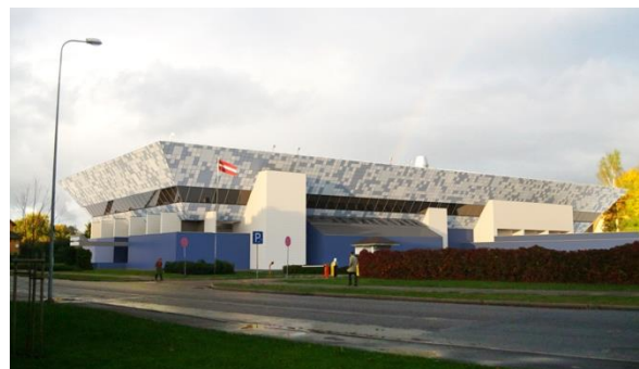
30.attēls Skats uz peldbaseina ēku Ķīpsalas ielā 5, Rīgā, no Ķīpsalas ielas puses
